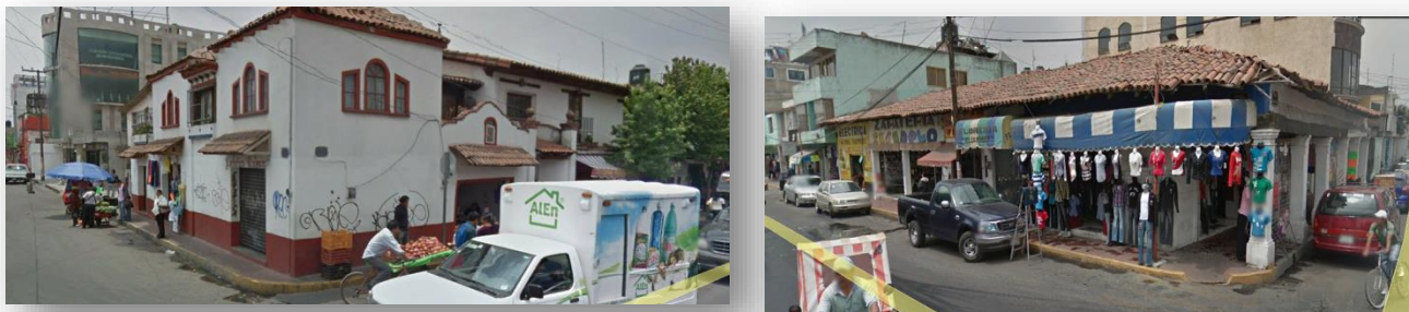
Figura 60. “Viviendas con una imagen deteriorada”.
