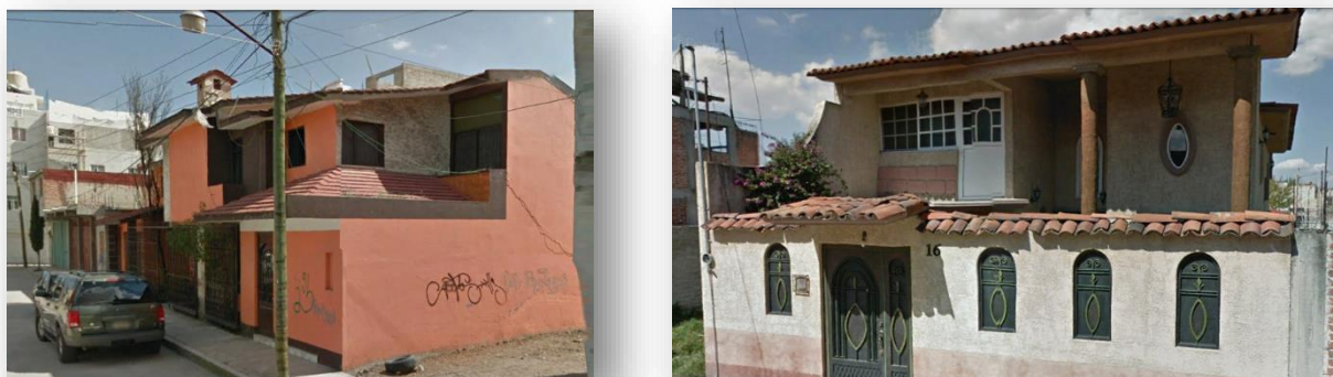
Figura 61. “Viviendas con una imagen deteriorada”.
