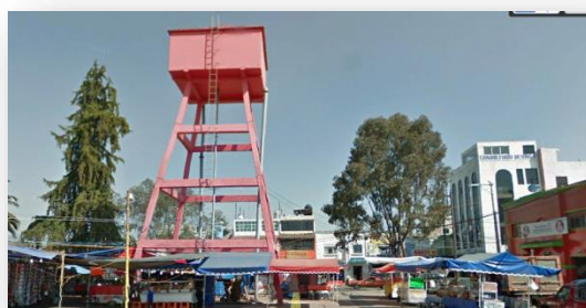
Tanque de Agua
